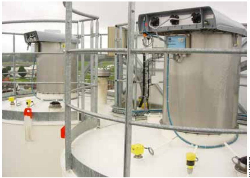
▲ Silos à ciment avec filtres de sécurité
